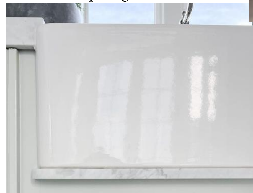
Drip Edge Below Sink
